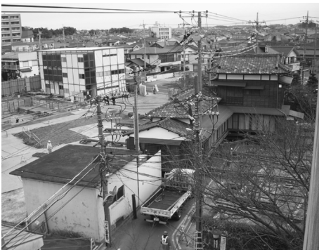
「曳家工法」の様子
