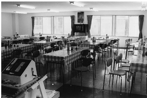
新築された食堂内部
