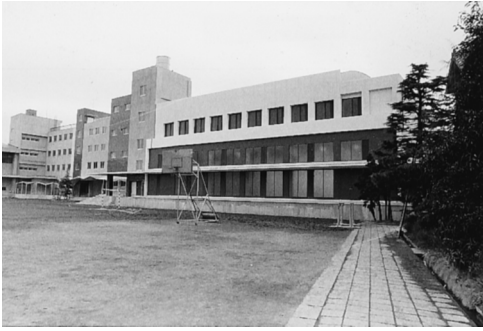
理科館・第二体育館
