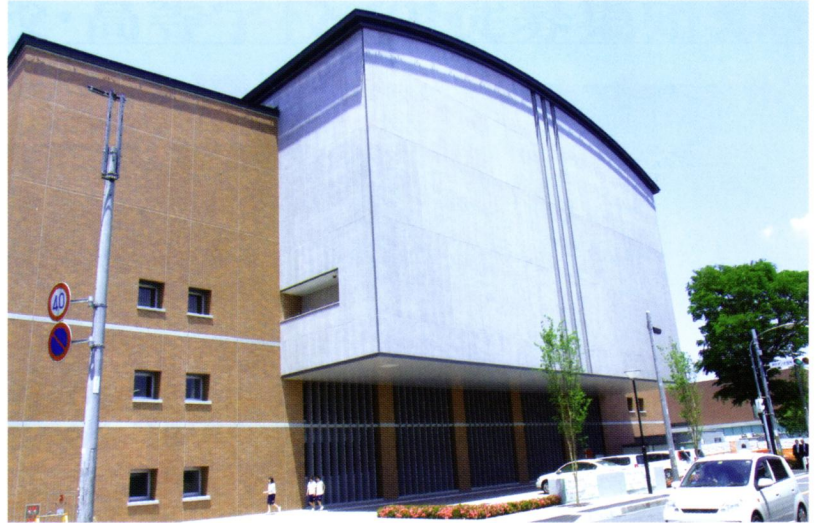
新体育館（1F：温水プール、第2アリーナ、武道場 3F：第1アリーナ）
